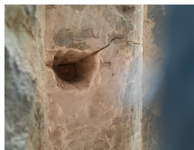
Plaats waar de verankering van het beeld is weggenomen, met het begin van de grote barst Foto © Frans Bockstael
