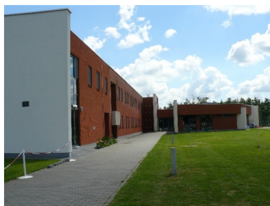
Het internaat vandaag
