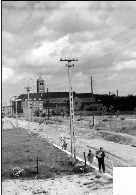
Aanleg Kerspelstraat in 1959.
