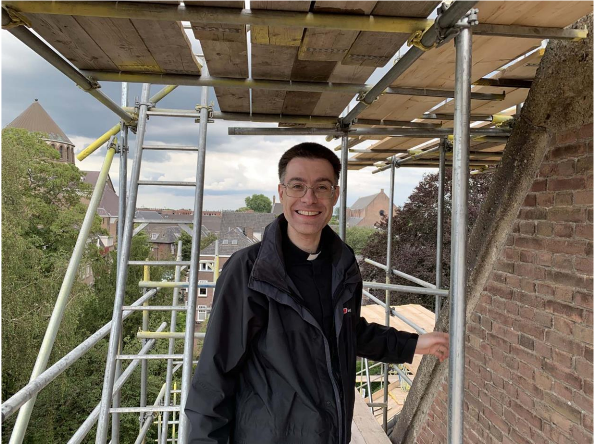
Priester Filip De Rycke bij de renovatiewerken aan het Sint-Janscentrum in 2020.
