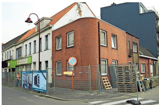
De huizen op de hoek van de Boomgaard met de Stationsstraat in het centrum worden gesloopt. Foto Joeri Seymourtier
