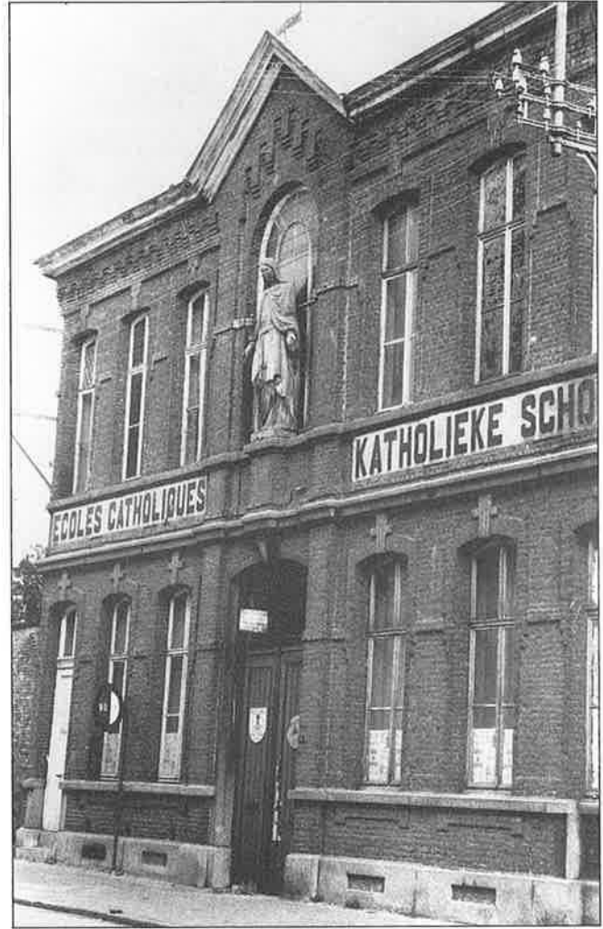
De voorgevel van de school op de "Hoogstraat" kort voor de afbraak. La façade de l'école de la "rue Haute" un peu avant sa démolition.
