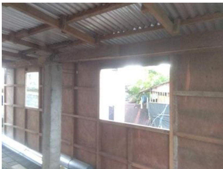
Woning Anthony – binnenzicht van de verdieping na renovatie.
