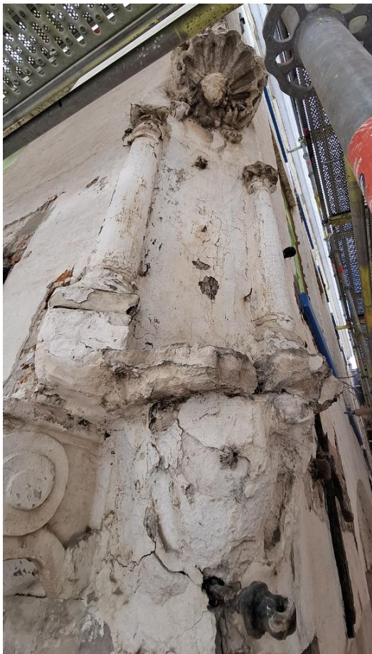
Nis voor restauratie (Foto Rephine Stoneworks)
