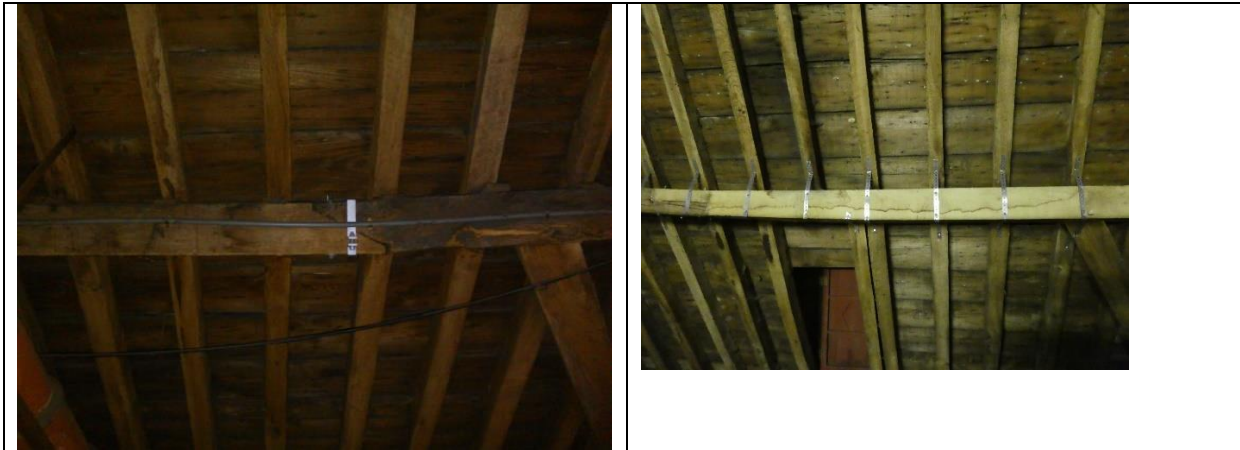
Figuur 13 a en b: een gebroken dwarsbalk aan de oostzijde van het schip werd voorlopig hersteld (a). Er werden eveneens in september 2015 voorlopige verstevigingen aangebracht aan doorzakkende dwarsbalken aan de noordoostelijke zijde van het schip (b).
