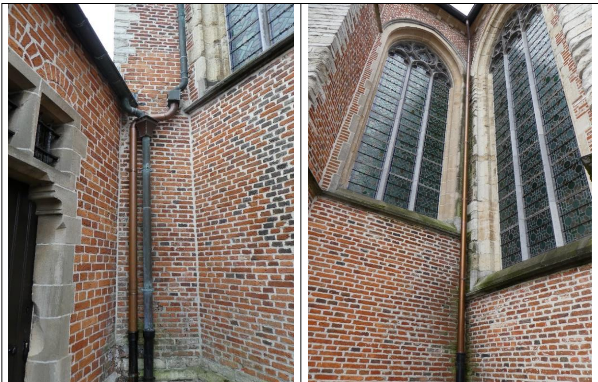
Figuur 14 a en b: de meest dringende herstellingen aan de dakgoten bij de achteringang van de sacristie (a) en het hoogkoor (b) werden uitgevoerd.
