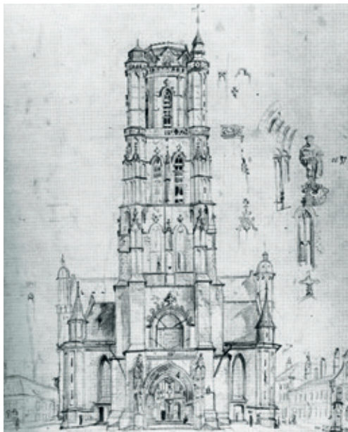
Potloodtekening (Zwarte Doos – Gent). Toestand van de toren voor de restauratie in de 19 de eeuw. Deze tekening is waardevol omdat er zoveel details op voorkomen die bij de restauratie verdwenen zijn: de houten afdekking van de hoektorentjes zowel boven op de toren als op de flankeertorentjes, de afwezigheid van een borstwering op de kapellen bij de toren, geen maaswerk aan het grote centrale raam...
